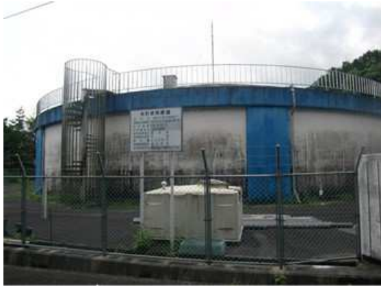
図表 2-9 越知上水道配水池
