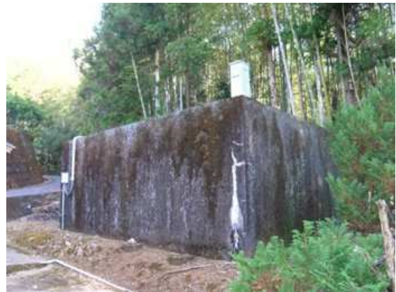
図表 2-12 片岡簡易水道配水池
