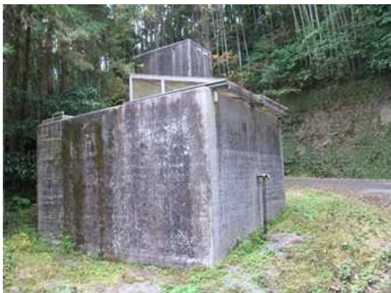
図表 2-13 楠神簡易水道配水池
