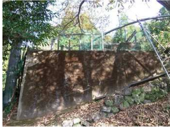
図表 2-15 鎌井田簡易水道配水池
