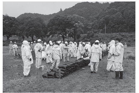
土のう積み工法
