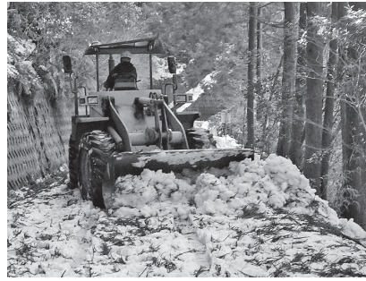
重機を使った除雪作業の様子
