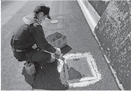
水利点検実施中の様子
