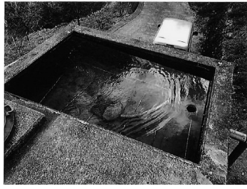
コンクリート製の施設
