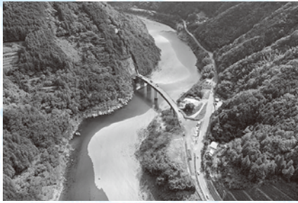
建設中の新今成トンネルと立花大橋
