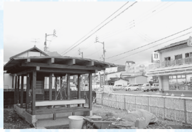
建設中の「越知のまち小屋（8区）」
