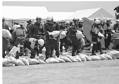
炎天下の中での土のう積工法！ 額に汗をかいて奮闘！
