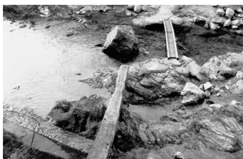
狩山川に架かる見ノ越への仮板橋
