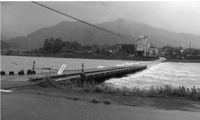
通行止めとなった中仁淀沈下橋
