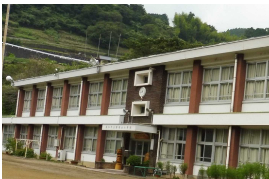
①外壁の落下、窓ガラスの割れはないか (校舎)
