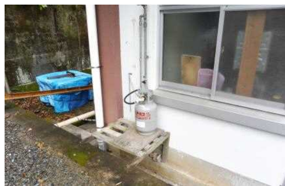
③プロパン置き場：転倒していないか ガス臭くないか
