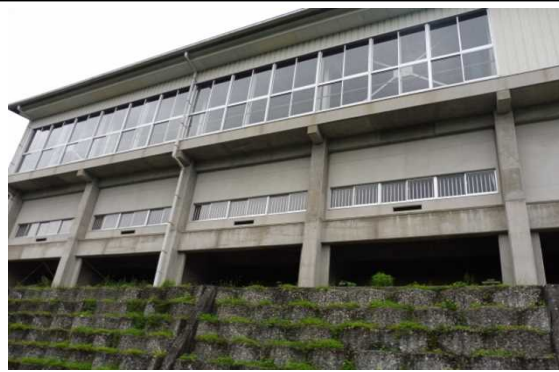
②外壁の落下、窓ガラスの割れはないか (体育館)
