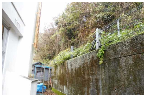
④校舎の裏：土砂崩れが起きていないか
