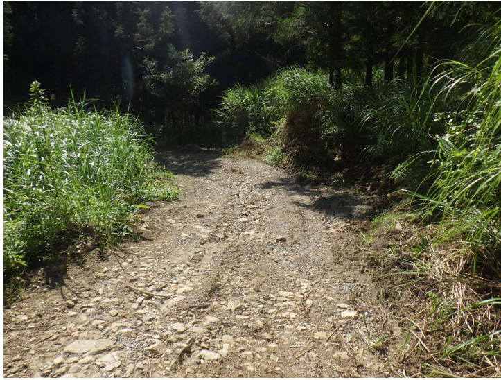
森林整備状況(作業道)
