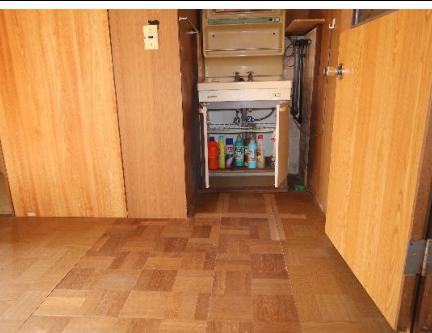
洗面所・玄関ホールの状況
