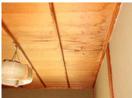
和室④天井の状況
