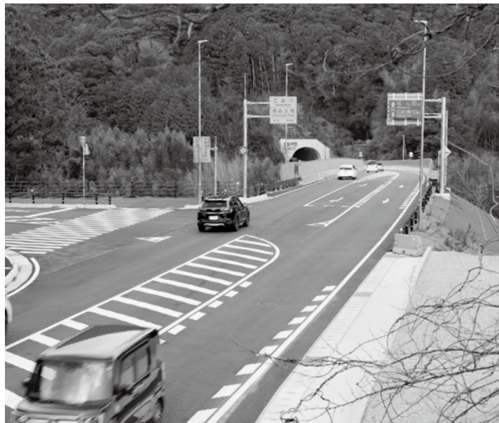
越知道路2工区バイパス区間
