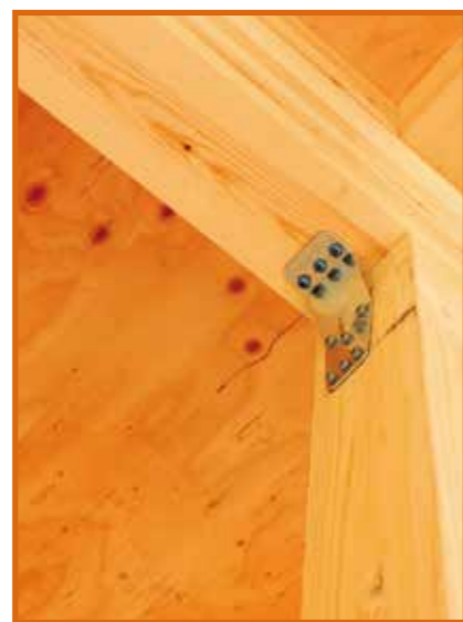
耐震補強金具施工例
