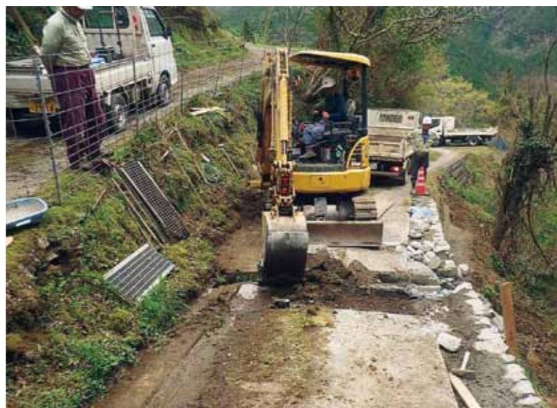
町道白岩谷ノ内線災害復旧工事
