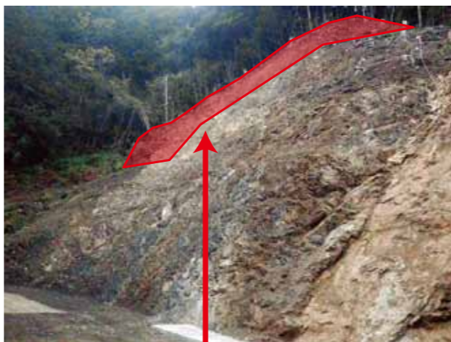
モルタル吹付工が増加した部分
