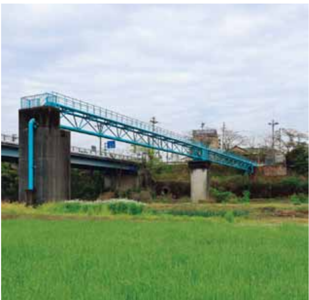
耐震化が望まれる水管橋
