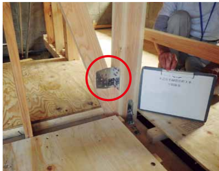
柱と筋かいの強度を上げる金具
