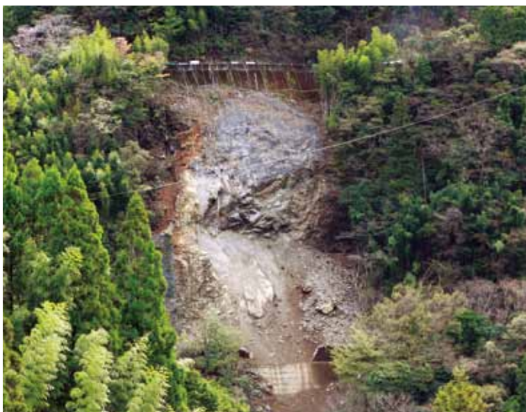
日ノ浦の災害工事
