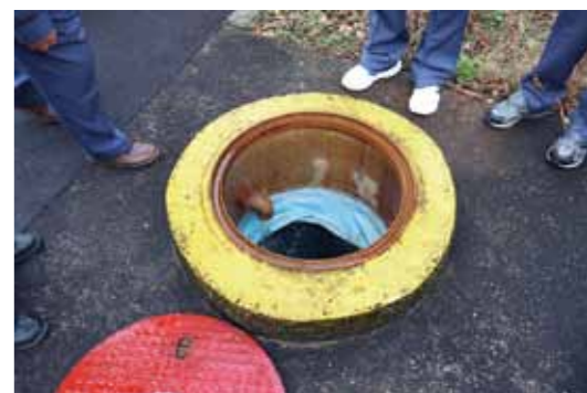
リブシート工法による耐震化
