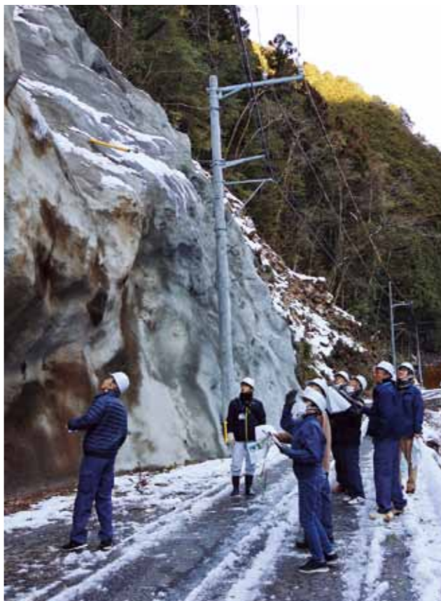
迫力ある法面工事
