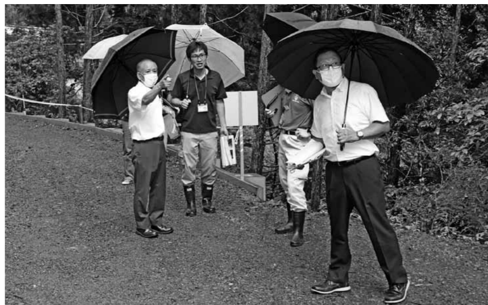
道路工事の説明を受ける監査委員
