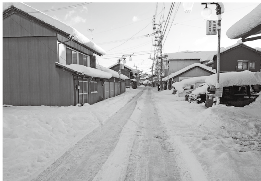
雪の重みで樋に被害が
