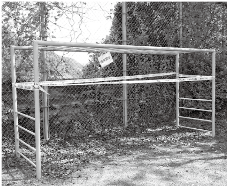
危険なため使用禁止となっている
