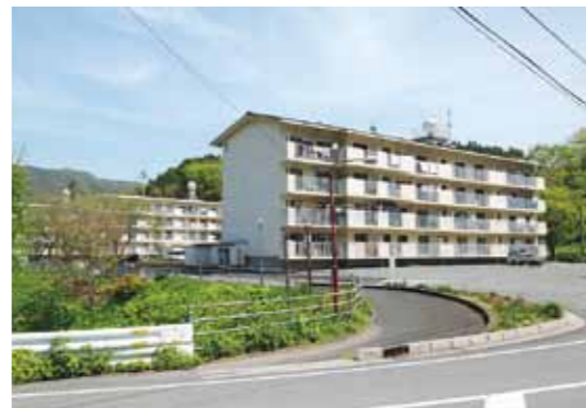
修繕の進む小舟団地
