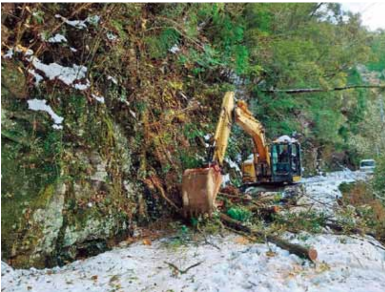
除雪・倒木撤去作業の様子
