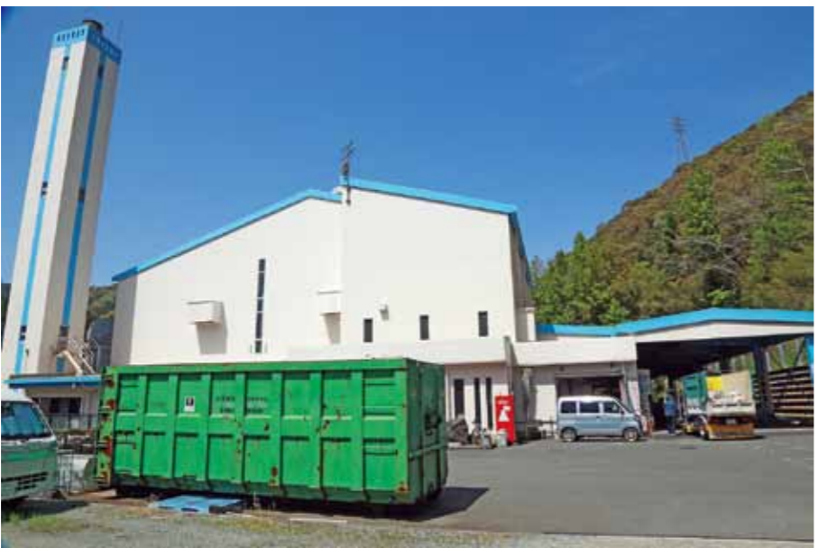
高吾北清掃センター
