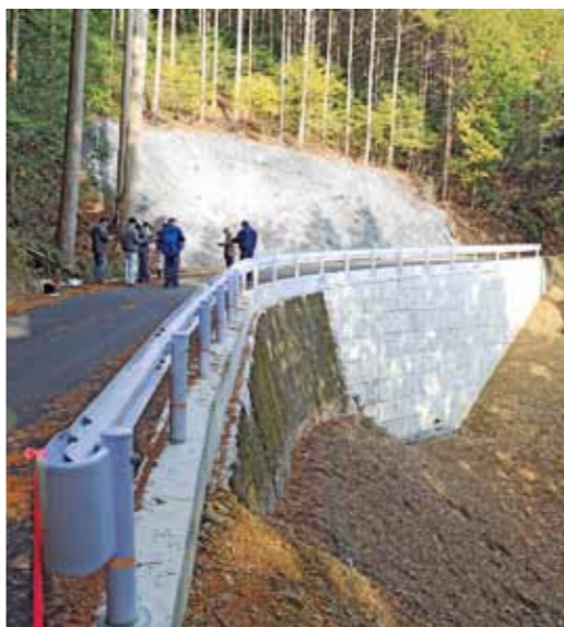
復旧で安心、安全になった林道
