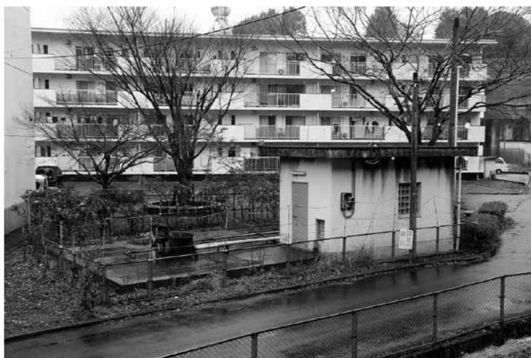
解体撤去される旧小舟団地浄化槽
