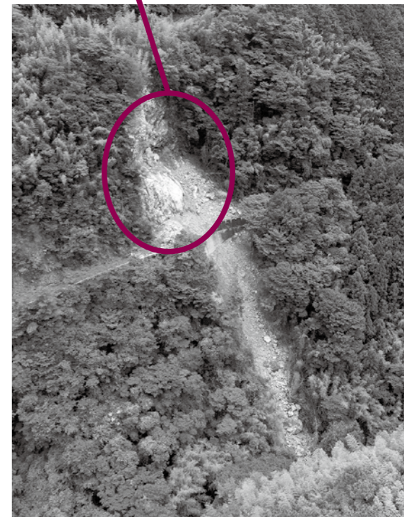
円で囲った部分が今回の工事箇所
