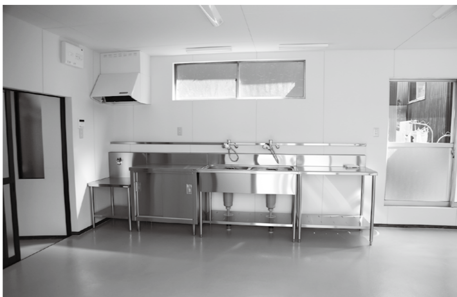
チャレンジショップで活用する調理室完成
