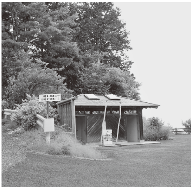
取り壊され水洗化される第1駐車場トイレ
