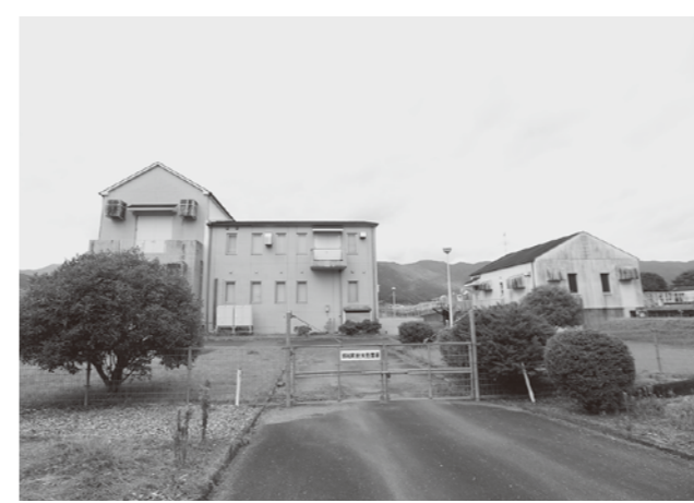
28年経過した浄化センター(女川)
