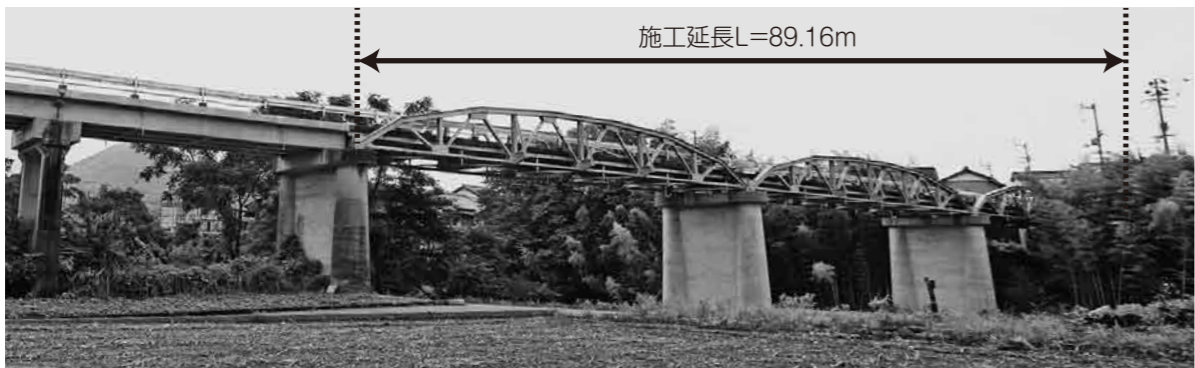
昭和4年に建設された坂折橋
