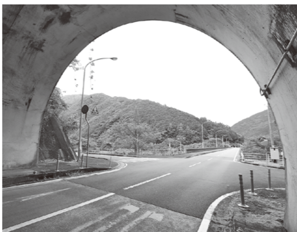
看板設置予定のトンネル出口付近
