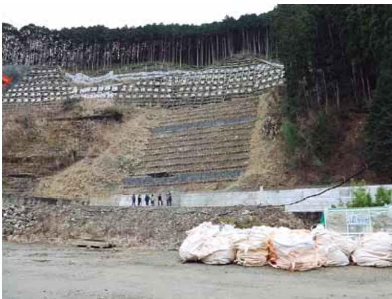
上部は県によるアンカー工事が完成(南ノ川)
