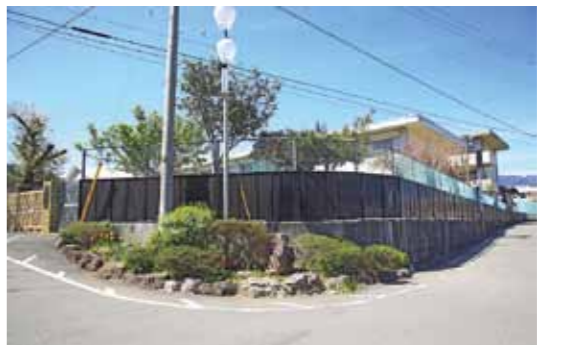
軽量フェンスに改修（施工後）
