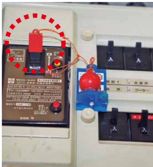
感震ブレーカー(点線部分)
