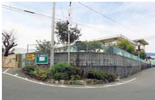
通学路にあるブロック塀（施工前）
