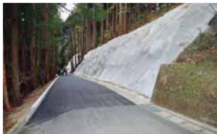
モルタル吹き付けとアスファルト舗装
