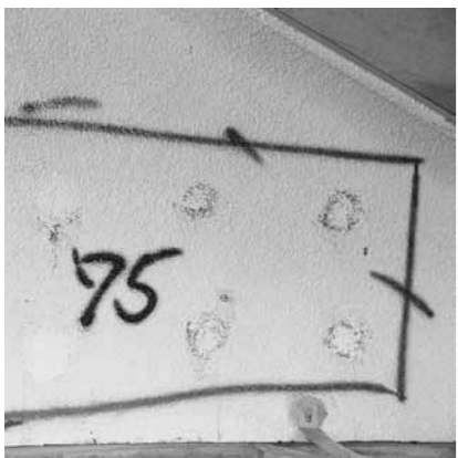
ひび割れ箇所に薬剤注入
