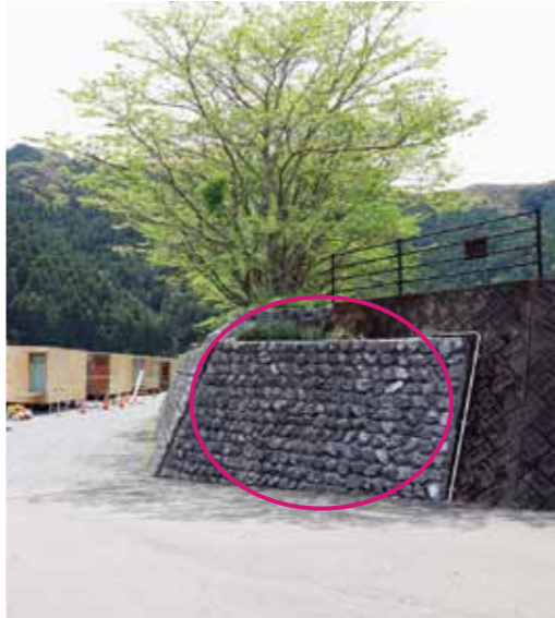
階段の設置が予定されている場所
