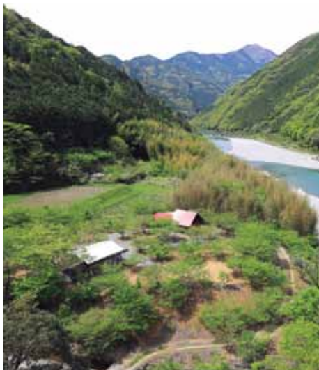
トイレは浸水の心配のない高台で
