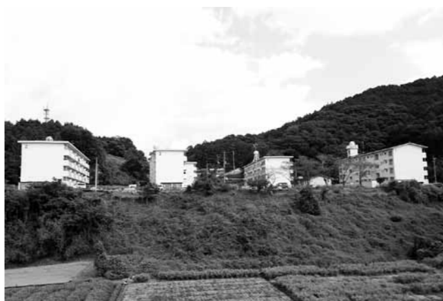
昭和53年度に一棟目が建築された小舟団地
