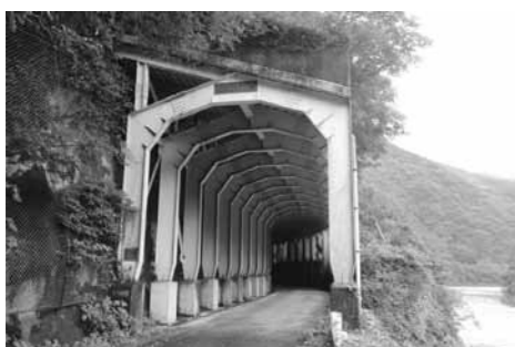
昭和55年建設の洞門(放水口)
