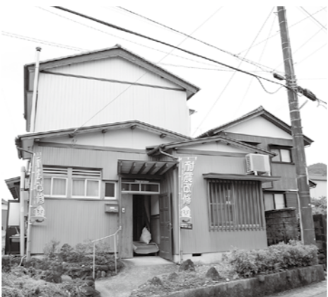
のぼり旗を立てて耐震改修（3区）
