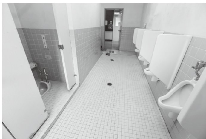
2年度改修予定の中学校トイレ
