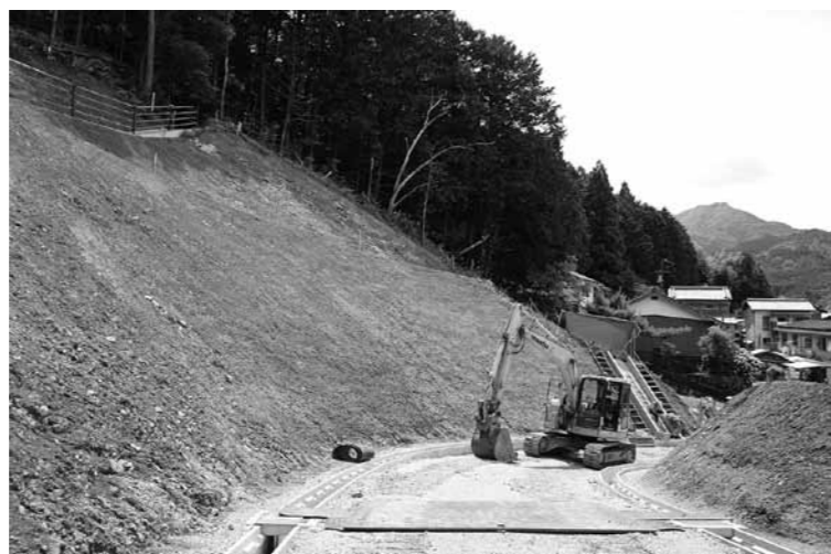
法枠工を予定している8区の工事現場
