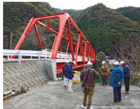
新設かと思うほどきれいになった宮ヶ奈路1号橋
