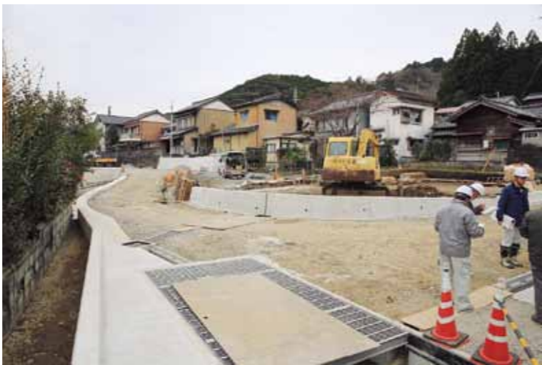
幅員が広がった町道向屋敷池ノ上線（8区）
