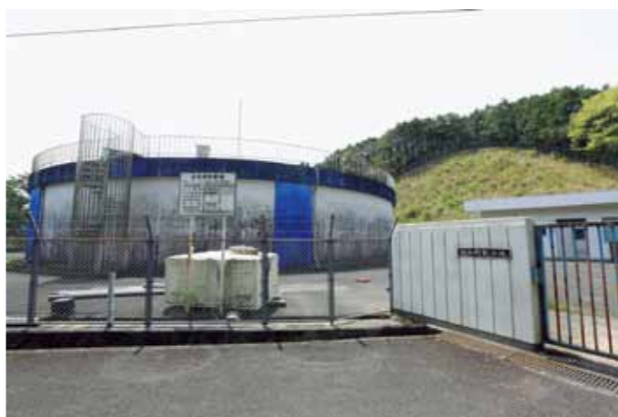
上水道と6つの簡易水道が統合（上水道配水池）
