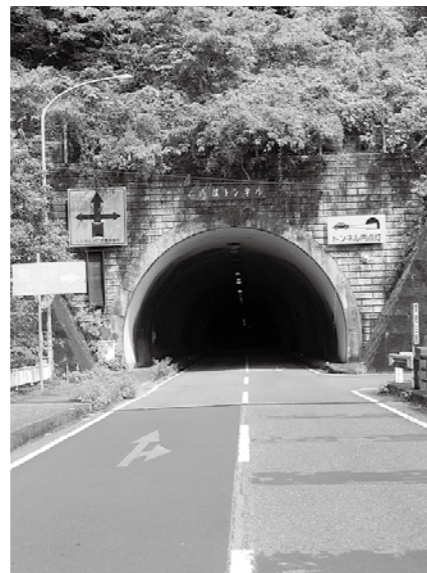
真っ暗な浅尾トンネル内
