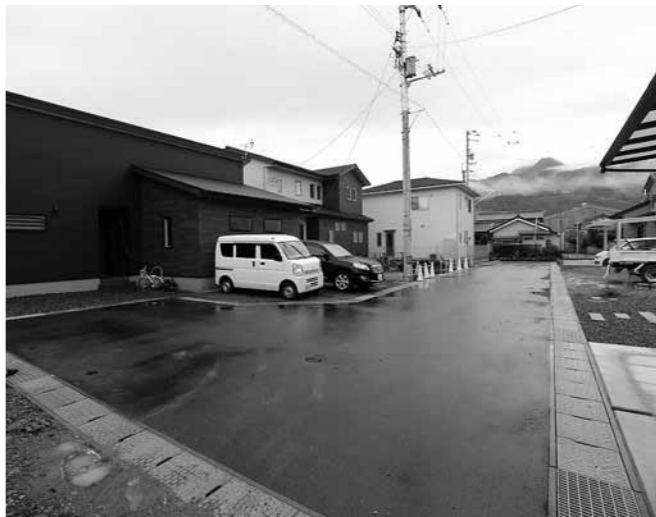
新たな住宅地となった6区
