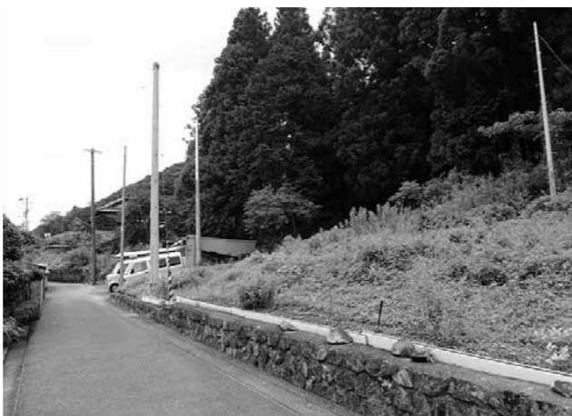
支障電柱を移転する町道向屋敷池ノ上線
