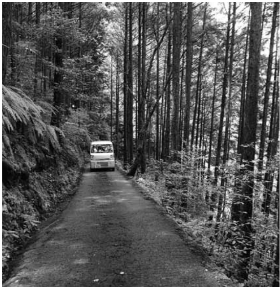
改良工事が予定されている町道大樽線
