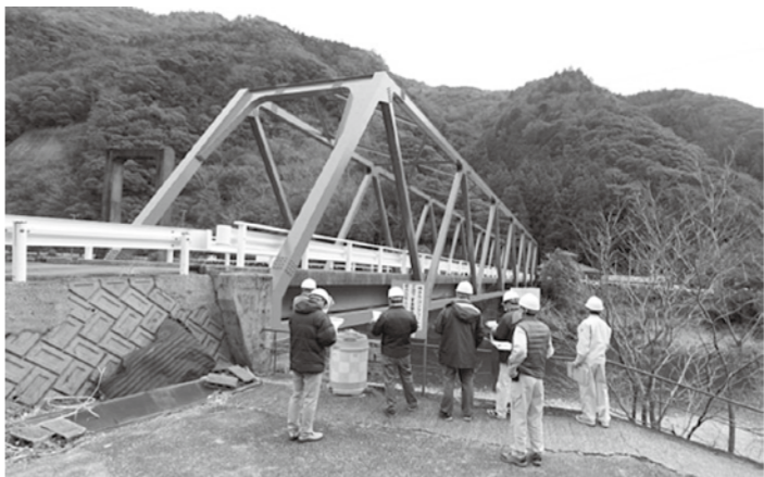
集落に通ずる唯一の橋
