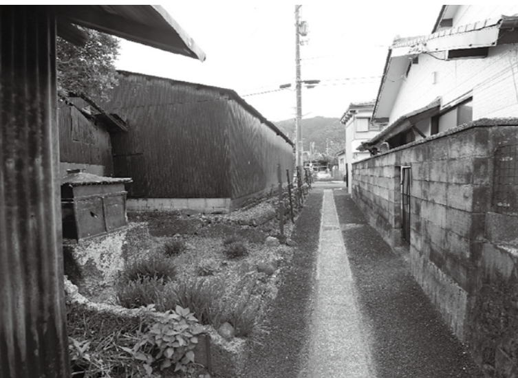
幅員の狭い町道西ノ芝4号線
