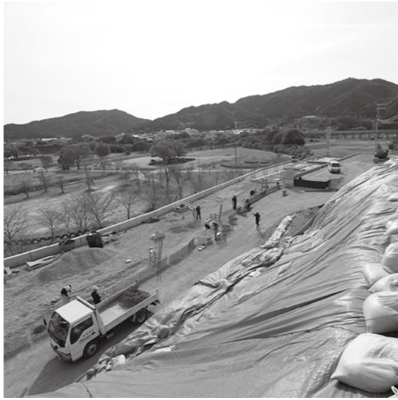
建設中の宮の前センターハウス
