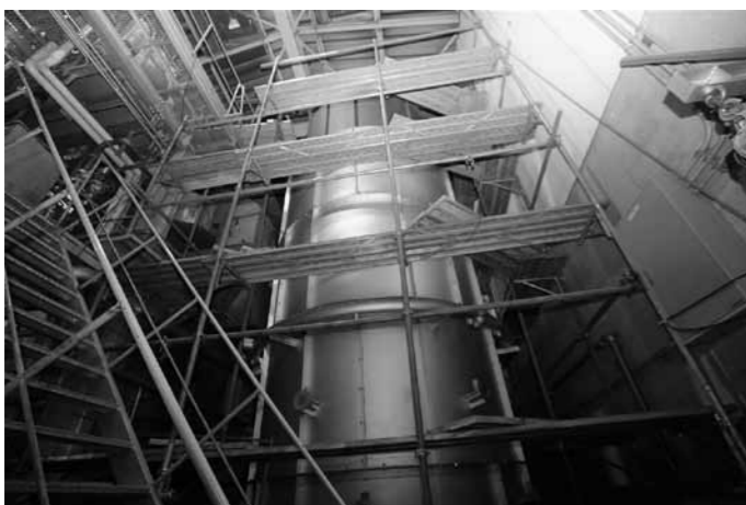
更新工事が行われている清掃センター2号炉
