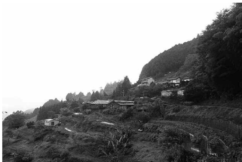
水道配水設備ができた柚ノ木の上地区
