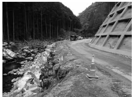
雪により路側工事が遅れた現場
