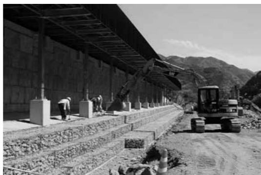
洗掘防止対策としての根止工(かごマット)
