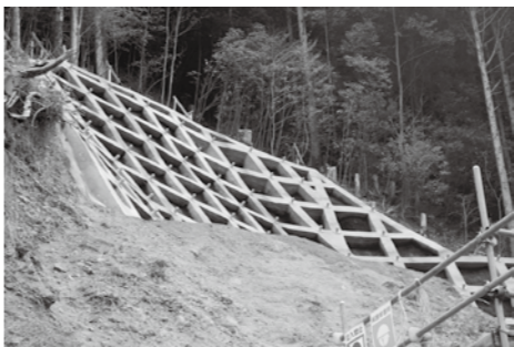
上部分は強固な施工が施されている
