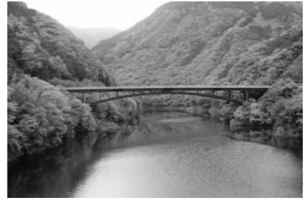
落橋を防止する筏津大橋
