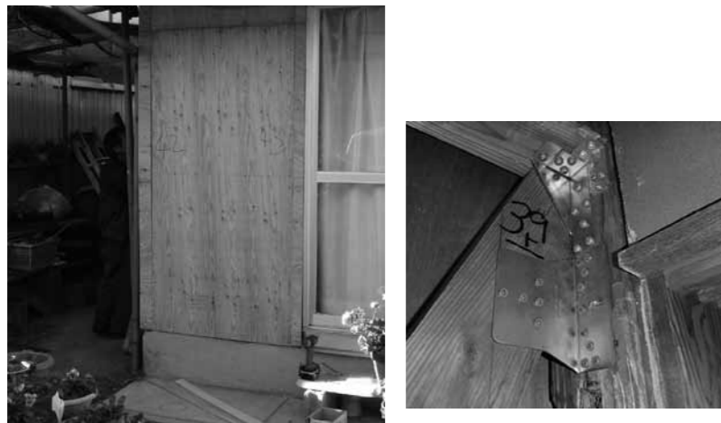
構造用合板と接合金物などで耐震補強がされる
