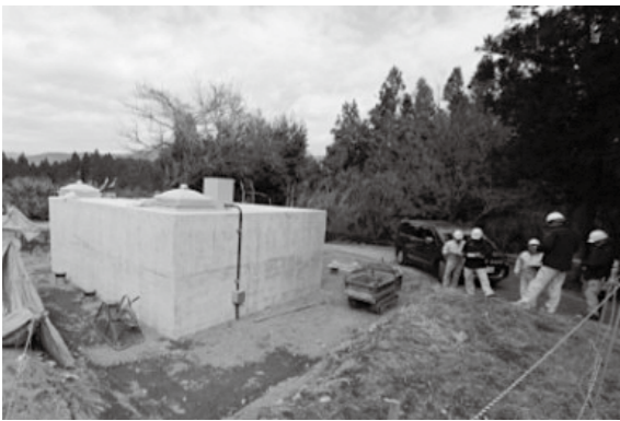
最上部にある第1配水池（17区2）
