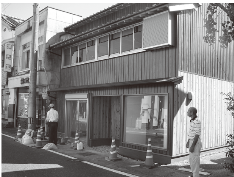
改修工事が完成間近となった西町商店街の拠点施設
