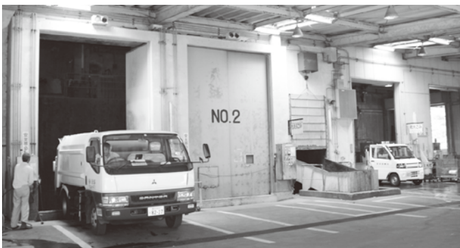
32年3月25日に工事の完了を目指す清掃センター
