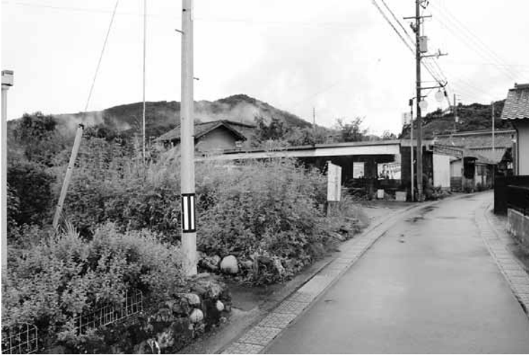
待避所が設置されると通行がスムーズになる(3区)
