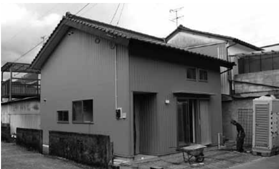
改修工事が行われている困窮者支援住宅
