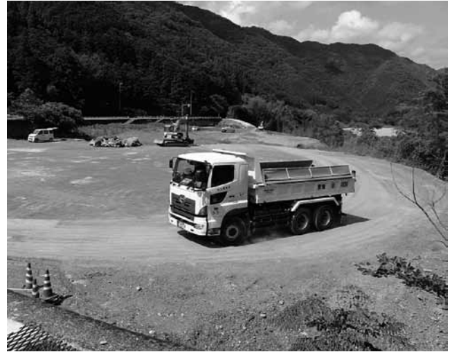
盛土工事が進んでいる日ノ瀬キャンプ場予定地
