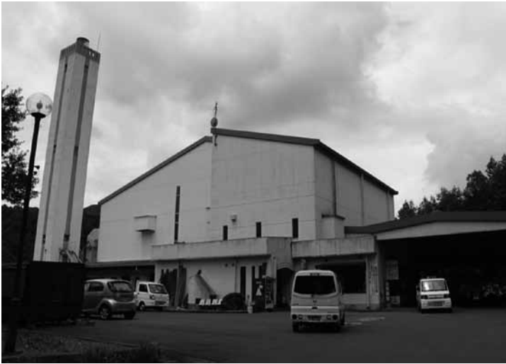
大規模な改修工事が行われる清掃センター
