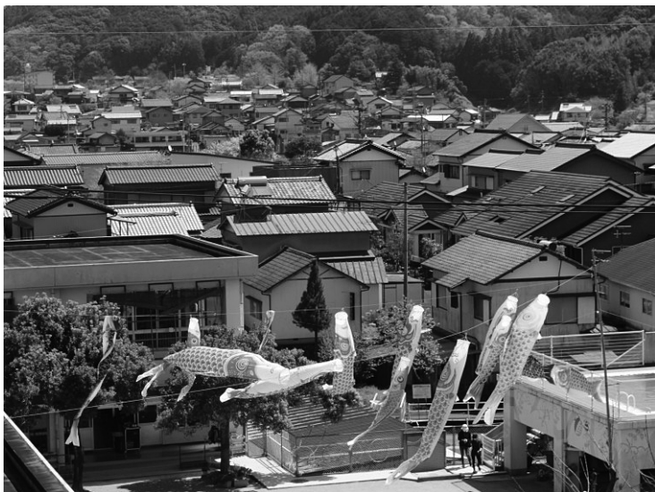
地震時に密集した市街地での避難路確保は重要だ（老朽住宅等除去）
