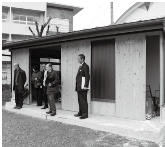
倉庫・トイレに段差がある
