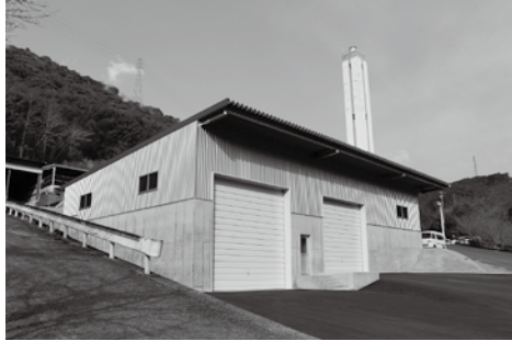
完成したストックヤード
