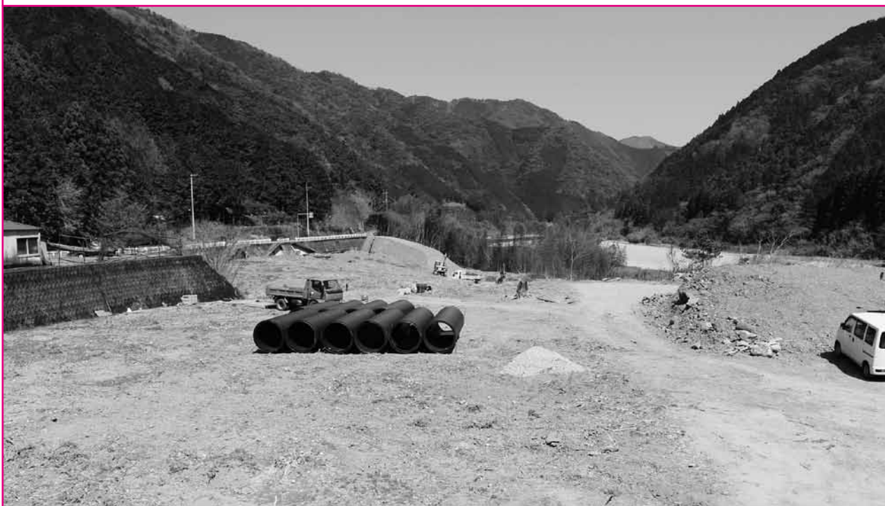
盛土工事が始まった日ノ瀬キャンプ場用地
