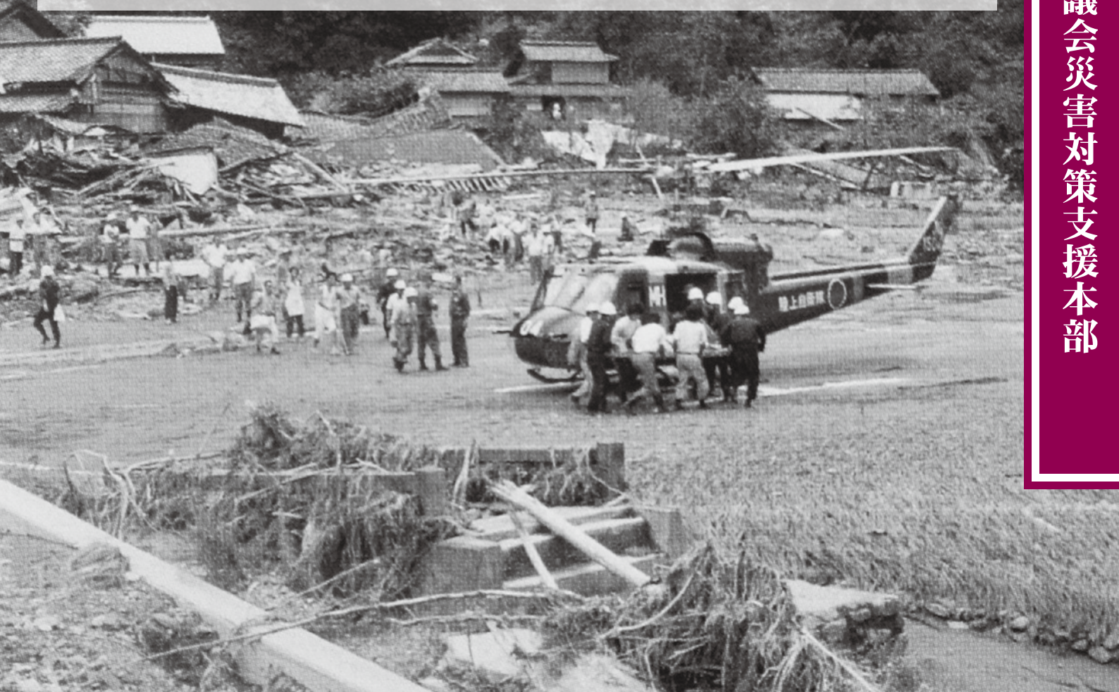
昭和50年8月の台風5号により甚大な被害を受けた宮ヶ奈路地区
