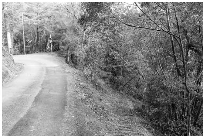
急勾配での難工事が予想される改良計画の終点付近
