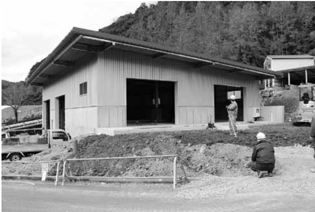
焼却場下に建設が進む焼却灰ストックヤード
