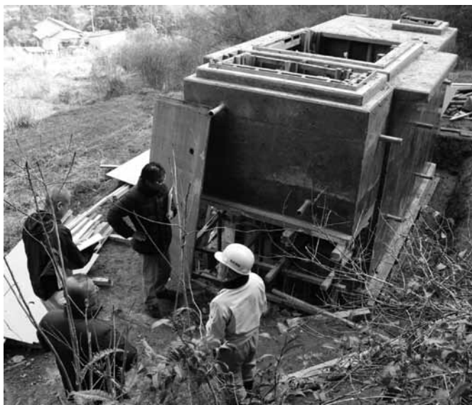
完成間近い大元地区の配水池
