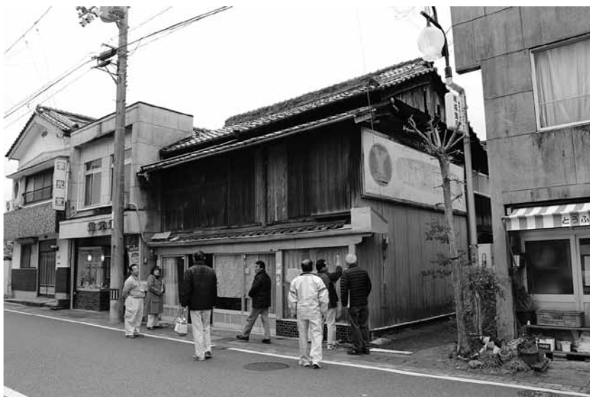
耐震を含めた改修工事が行われる9区の空き店舗
