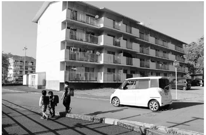
修繕管理を県の住宅供給公社に委託する小舟団地
