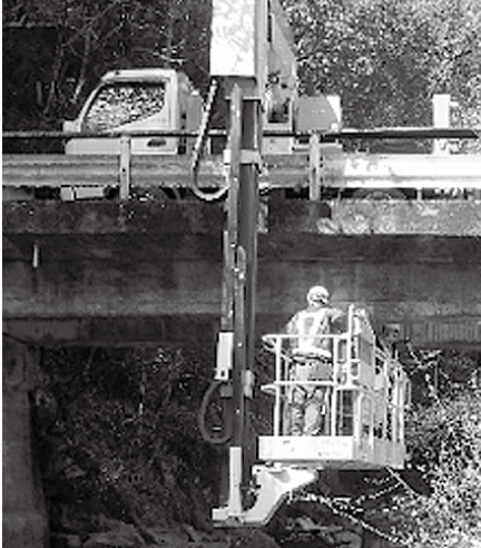
西浦橋の点検の様子
