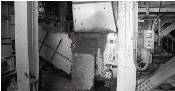
大規模改修される清掃センター
