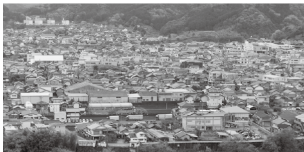
2区から10区までが延焼防止重点推進地域に指定されている
