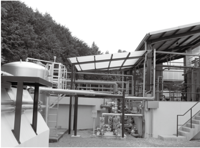
改修工事が完了した衛生センター
