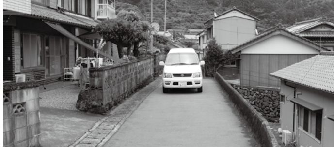
待避所設置が望まれる鎌井田集落内
