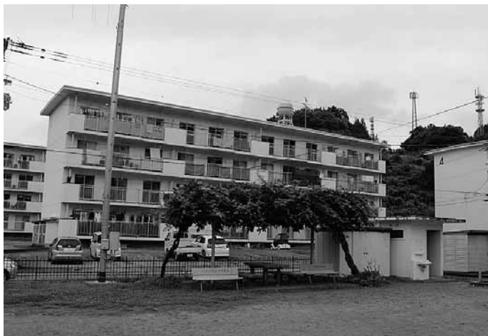
建築から30年以上過ぎ老朽化が進む小舟団地
