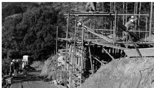
急ピッチで工事が進む
