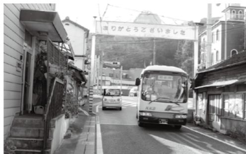
東側の支柱が危険
