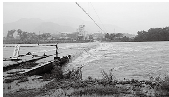
台風などの増水時に通行止めとなる中仁淀橋
