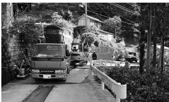
水道工事が始まった宮地下地区
