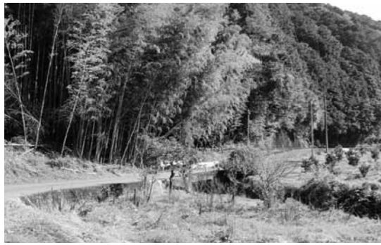
仁淀川の増水でたびたび冠水する宮地下（ドウバタ）の橋のかさ上げ工事が待たれる現場
