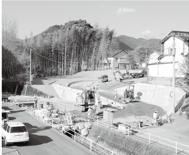
住宅西側からの進入路が整備されている
