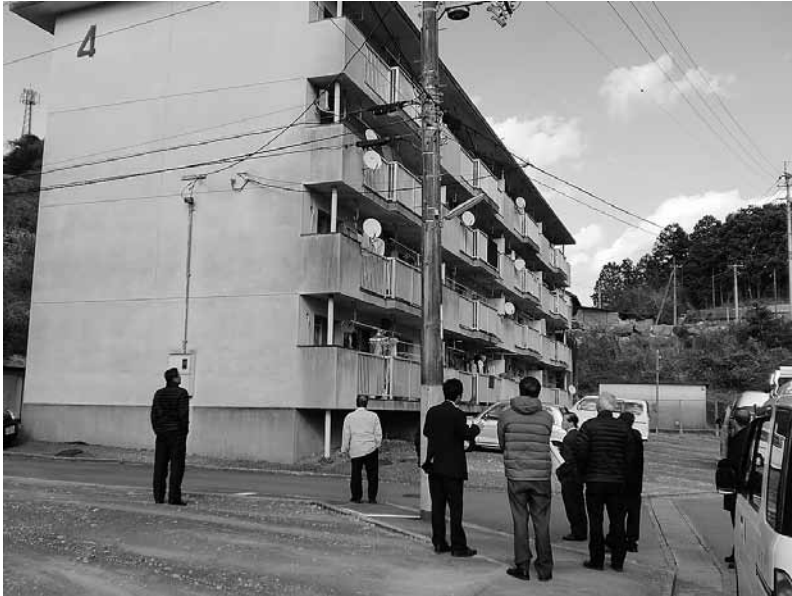
屋上防水と外壁改修をする4号棟
