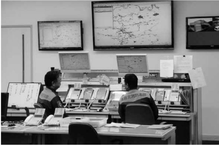
消防業務の中枢である通信指令室
