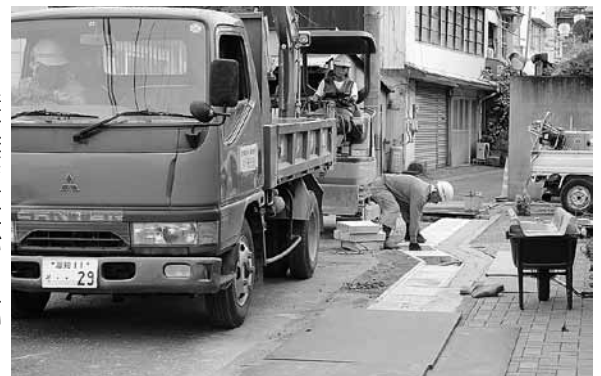
側溝改修で道路がきれいに
