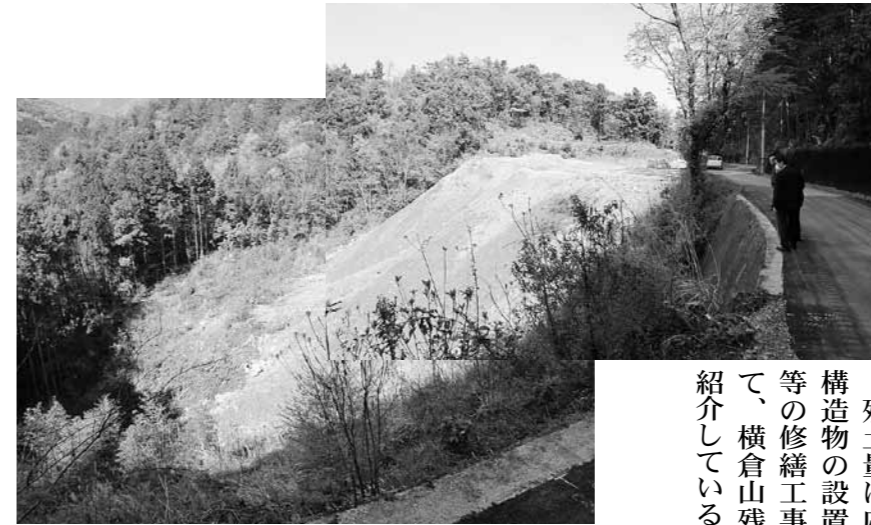
土砂の流出を防ぐ対策が必要となっている
