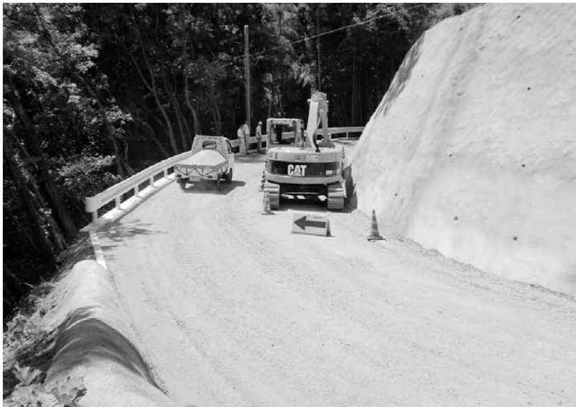
舗装の完成を待っただけの町道山室線
