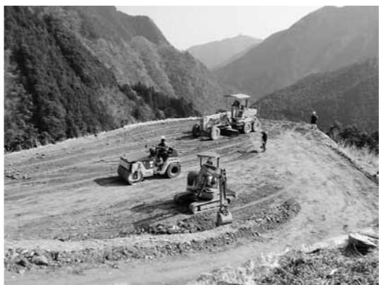
完成に向け舗装工事が進むヘリポート
