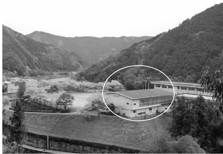
屋根の腐食が進む明治中学校体育館
