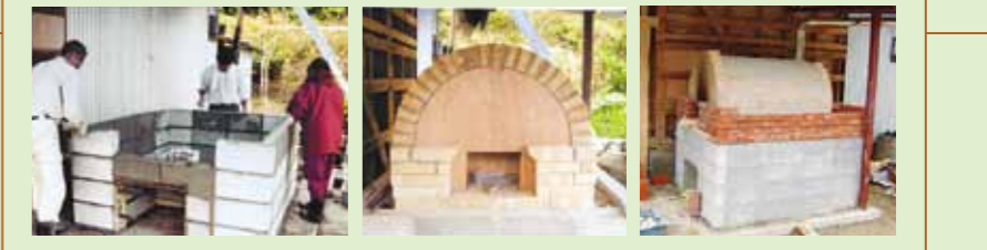
耐火レンガの外を赤レンガで覆う二重構造で、間に砂を詰めて保温性を高めている
