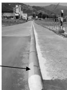
沈下橋上の水道管
