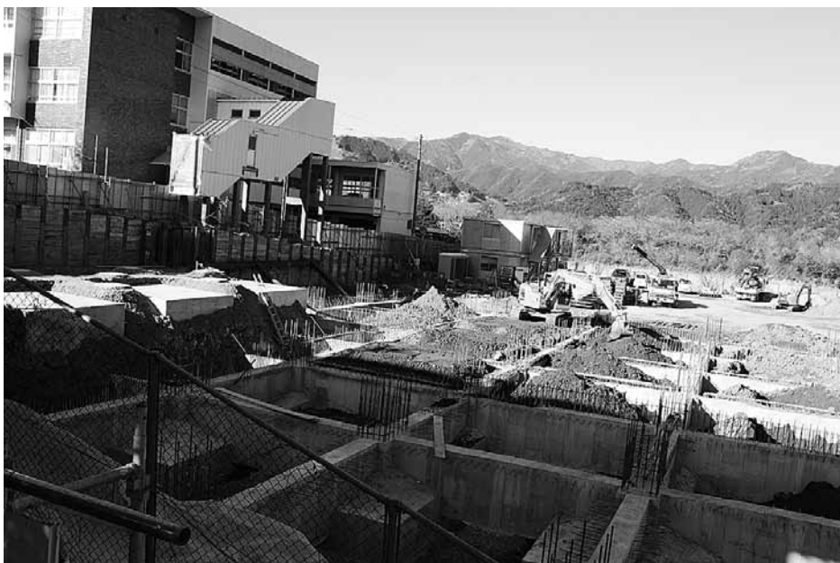
2学期までの完成を目指して工事が進む
