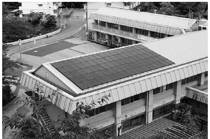
町民会館に設置している太陽光発電
