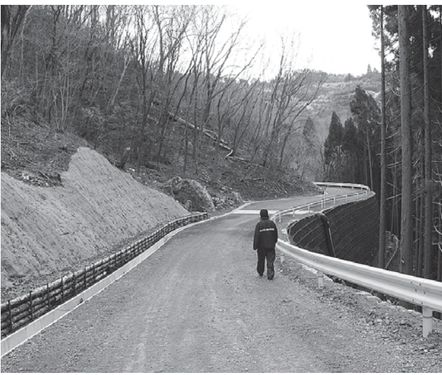
葉山（津野町）に向けて工事が進む林道小日浦線
