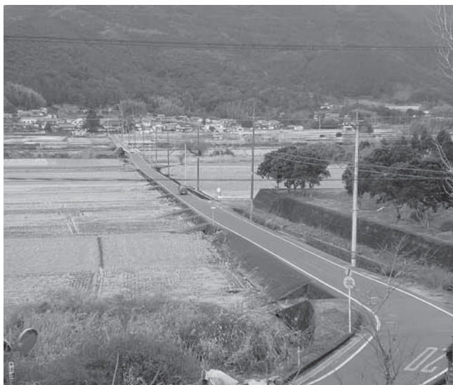
増水時に冠水する県道柳瀬越知線 (女川下水処理場付近から柴尾一本杉方向)
