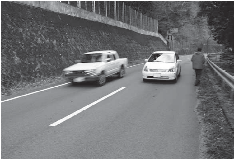
車の通行には支障はない状況
