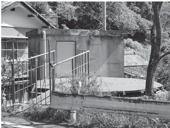
旧ポンプ室の上を鉄板で覆っている
