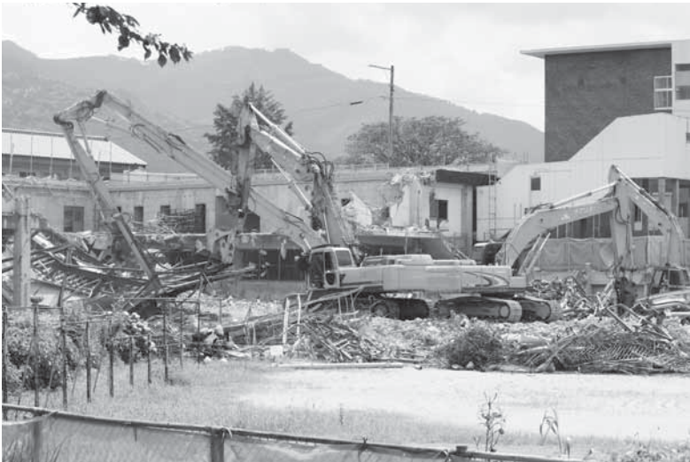
生まれ変わるため取り壊された体育館とプール（7月9日撮影）
