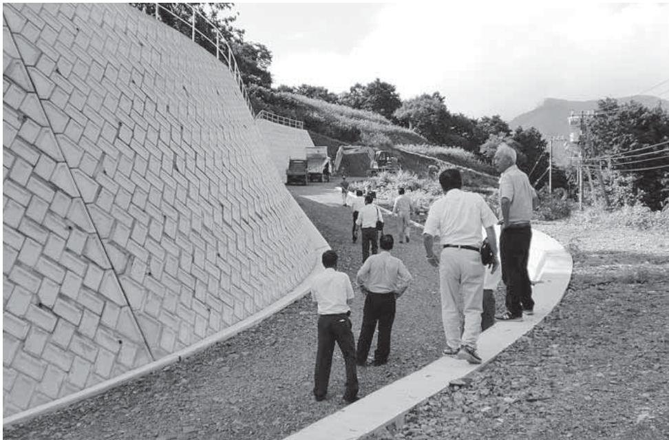
道路工事の状況を視察（9／18 決算現地調査・熊秋）
