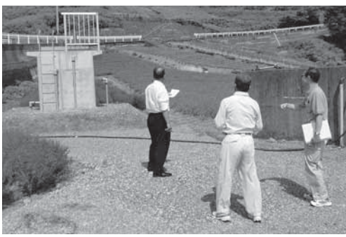
深瀬簡易水道施設を調査
