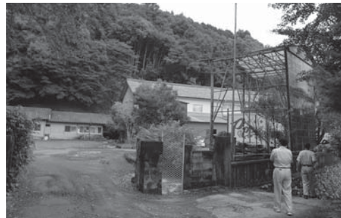
民間会社に貸している旧堂岡小学校
