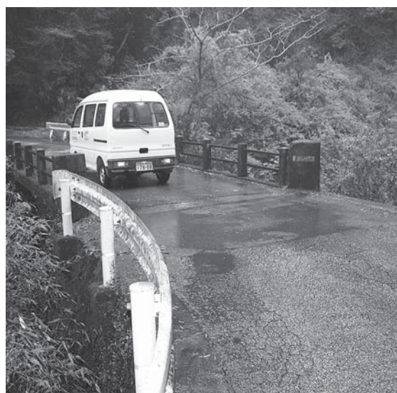
天神橋から文化橋付近は急峻で改良が難しい
