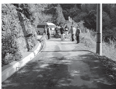
狭い道も側溝改修で通りやすくなる (町道鎌井田桑敷線)
